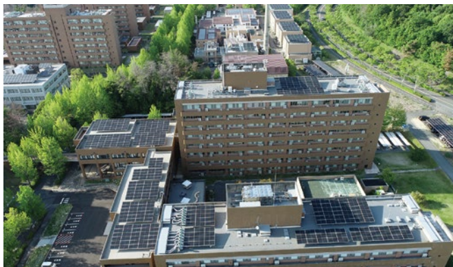
太陽光発電設備の設置(東広島キャンパス)
