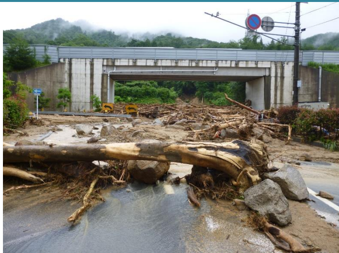
国道2号線西条バイパス付近の溪流から流出した土石流と流木（東広島市）
