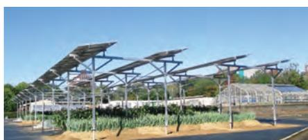
ソーラーシェアリング(営農型太陽光発電)は、農地に支柱を立てて上部空間に太陽光発電設備(ソーラーパネル)を設置し、その下で農作物を栽培することにより、太陽光を農業生産と発電に共有する取組です。一般住宅向けや産業用のソーラーパネルは未利用地や建物の屋上に設置されますが、ソーラーシェアリングでは農地の上で太陽光発電を行う農業の新しい取り組みです。後継者不足、高齢化、耕作放棄地の増加など、農業では多くの問題を抱えている中で、ソーラーシェアリングは、休耕地、耕作放棄地の有効活用、新たな雇用の創出や再生可能エネルギーの導入による環境と調和した農業経営が期待でき、SDGsの達成に貢献します。
